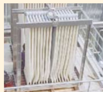
Les membranes sont formées par des fibres creuses associées en modules qui sont regroupés dans des cassettes.
